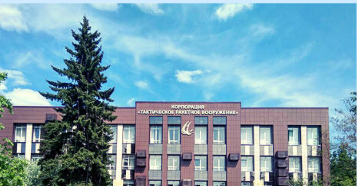
г. Рязань, Конструкторское бюро "Глобус" Компания Аэрдин осуществила поставку • Вытяжные и приточные вентиляторы систем ПДВ • Шкафы управления
